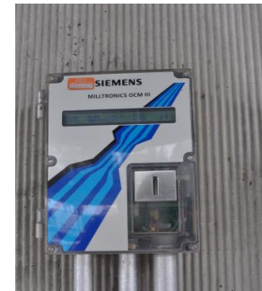
Effluent Flowmeter
