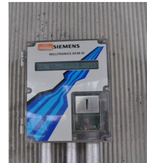
Effluent Flowmeter
